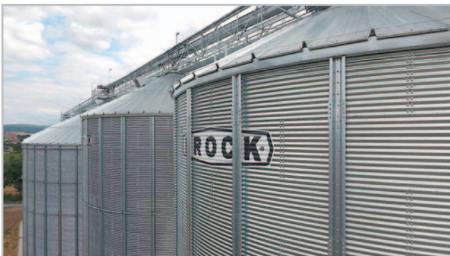
Inovativní střešní řešení sil Brock obvodového provzdušňovacího průduchu Eave Vent Kit, který zamezuje tvorbě kondenzátu pod střechou sil a společně s hladkou střechou chrání uskladněnou komoditu před atmosférickými srážkami. Foto archiv společnosti Pawlica
