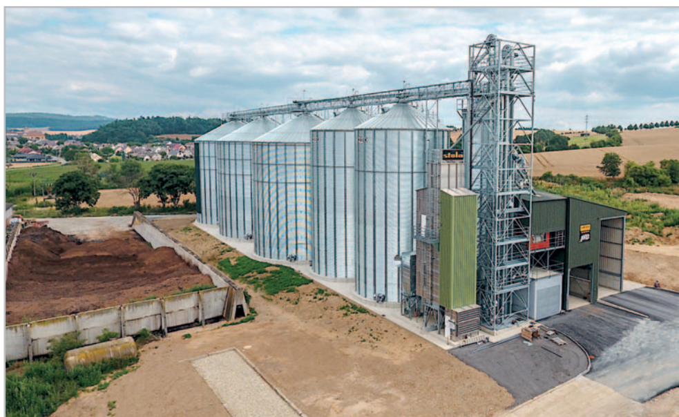
Realizace projektu posklizňové linky Pawlica v Úsově v Olomouckém kraji zahrnující výstavbu pozinkovaných amerických obilních sil Brock řady Everest, která jsou umístěna v liniovém uspořádání pro jednodušší organizaci a obsluhu celé linky. Foto archiv společnosti Pawlica
